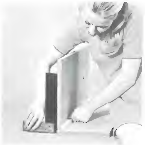
Fig. 6 - Posizionamento di un listello-angolare. Per far sì che tutto risulti in piano è conveniente impiegare una squadra da falegname
